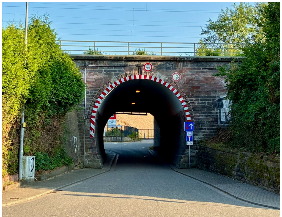
Abb. 6: Bauwerk zur Aufweitung aus städtebaulichem Interesse bzw. für den neuen Standort des Helmholtz Forschungszentrums für Informationssicherheit CISPA Quelle: W. Ried
