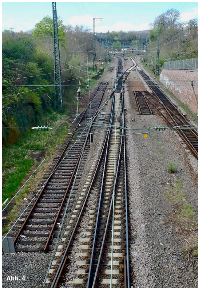
Abb. 4 und 5: Ostseite von Saarbrücken Hbf (aufgenommen im April 2012) umgestaltet im Kontext ESTW-Ausrüstung 2004 mit der Strecken nach Straßburg und Mannheim derart, dass nicht mehr parallel ein- und ausgefahren werden kann. Der Sparpolitik war zunächst sogar der geordnete Abbau nicht mehr genutzter Gleise zum Opfer gefallen. (Aktueller Zustand rechts) Quelle: [10]
