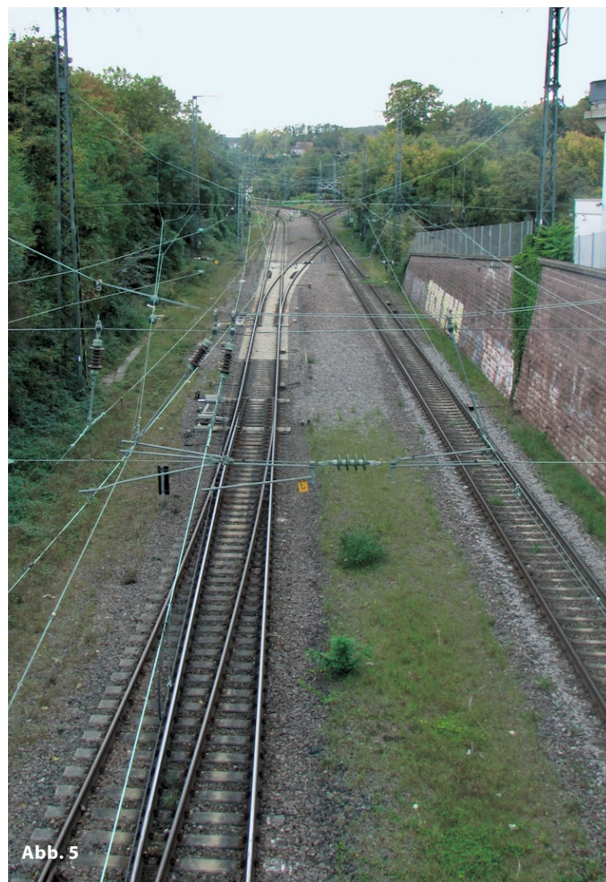
Abb. 4 und 5: Ostseite von Saarbrücken Hbf (aufgenommen im April 2012) umgestaltet im Kontext ESTW-Ausrüstung 2004 mit der Strecken nach Straßburg und Mannheim derart, dass nicht mehr parallel ein- und ausgefahren werden kann. Der Sparpolitik war zunächst sogar der geordnete Abbau nicht mehr genutzter Gleise zum Opfer gefallen. (Aktueller Zustand rechts) Quelle: [10]
