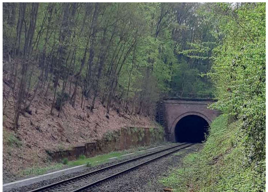
Abb. 6: Nordportal des 436 m langen Altenhoftunnels zwischen Hochspeyer und Enkenbach-Alsenborn
