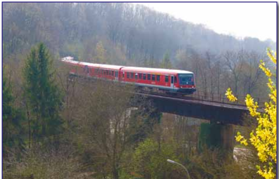
Karfreitag-Sonderzug auf dem Viadukt bei Niedaltdorf.
