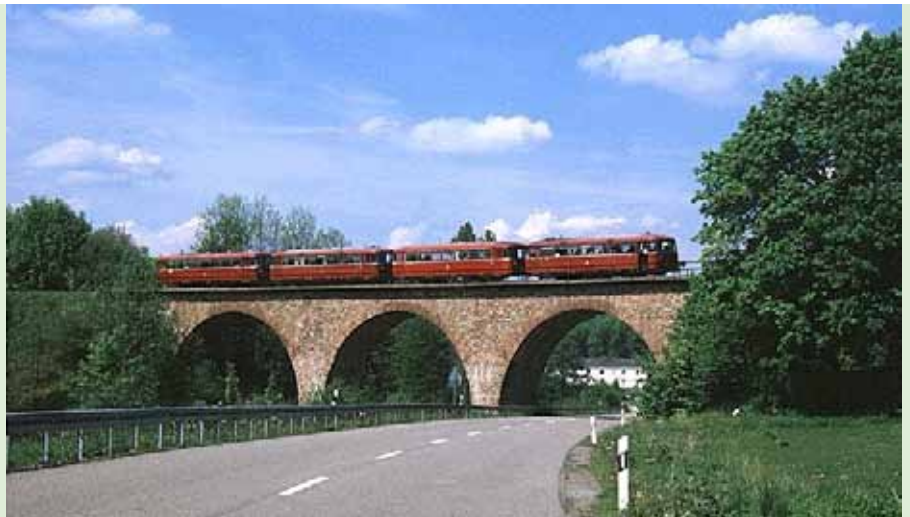
Sonderzug auf dem Nonnweiler Viadukt.
